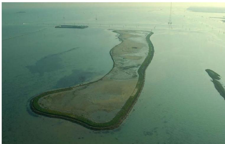
fig. 53 Fonte: Consorzio Venezia Nuova, barena Canale Fusina, realizzata nel 2006 lungo il canale Malamocco-Marghera. Questa struttura con funzione di canalizzazione e intercettazione è realizzata con una conterminazione di burghe e materassi disposti su più livelli per proteggere il margine dal moto ondoso da vento e dalle onde e correnti prodotte dalle navi .
