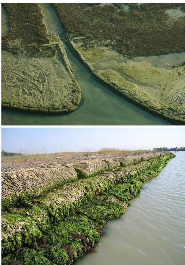
fig. 56 Fonte: Consorzio Venezia Nuova, fascinata di sedimentazione: canale Scanello a Burano (sopra) e barena canale Dese (sotto).
