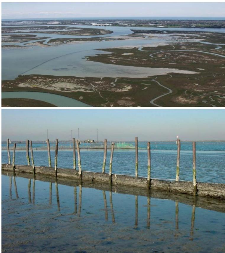
fig. 57 Fonte: Consorzio Venezia Nuova, Canale di Burano. Protezione in burghe. Riempimenti a tergo e raccordo con il ghebo esistente (sopra); La colonizzazione delle burghe da parte di organismi bentonici riguarda soprattutto la fascia di escursione di marea, mentre la fascia inferiore a diretto contatto con il piano sedimentario è colonizzata da una comunità semplificata (sotto).
