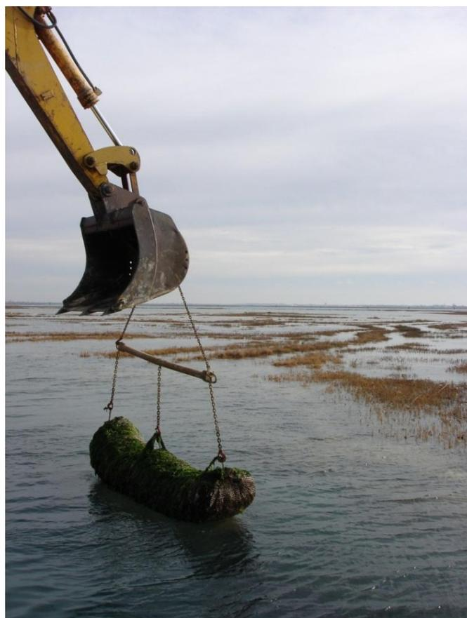
Figura 6. Operazione di rimozione delle burghe lungo il canale di Burano.
